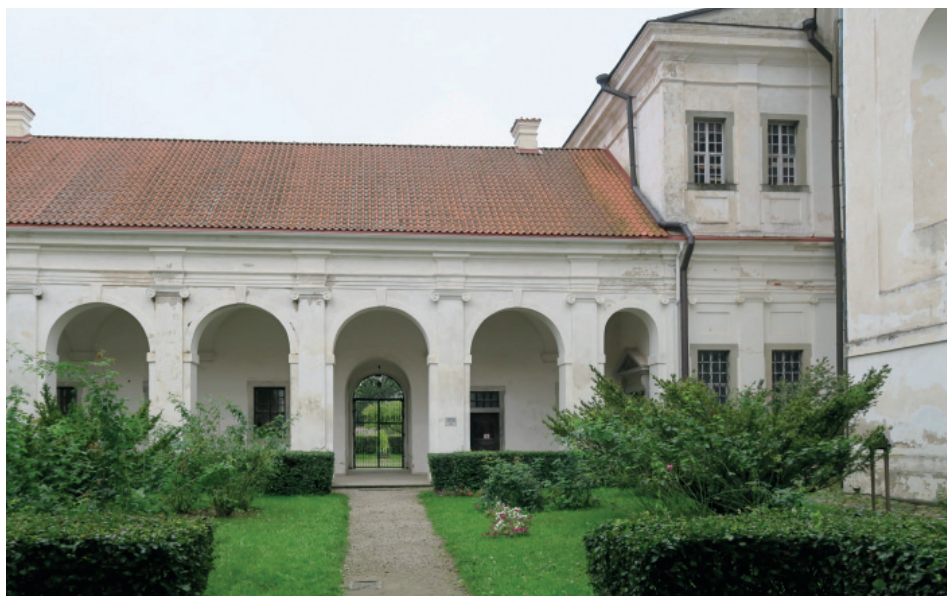
Il. 10. Pożajście, ogród w wirydarzu północnym z bramą do eremitorium i fragmentem kościoła, fot. M. Rozbicka, 2016
